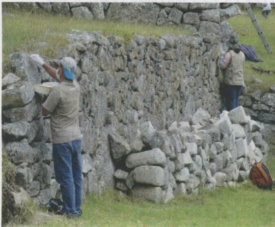
↑修復中のマチュピチュ遺跡の石積み 市街地への入口→
